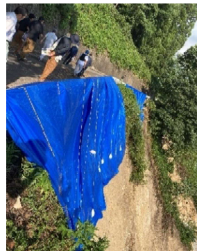
【三光堰水路法面崩落】
