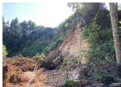
【取水堰上流部法面崩壊】
