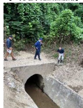
【三光堰水路トンネル】
