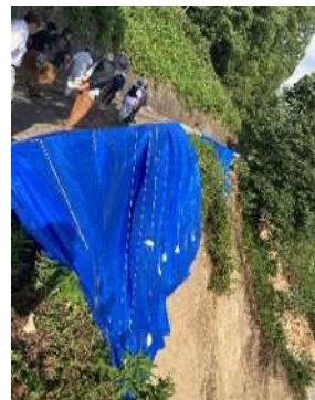
【三光堰水路法面崩落】
